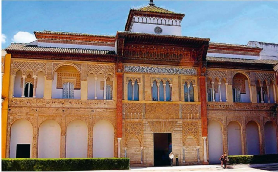
Portada del palacio de Pedro I, parte del complejo monumental del Real Alcázar de Sevilla y concebido para servir como edificio privado del monarca.
